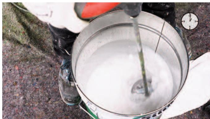
Weniger ist mehr: Die Silikal-Füllstoffe SL und SV, die jetzt beim Mischen deutlicher weniger Staub freigeben, sorgen für mehr Arbeitsschutz auf der Baustelle. Seit dem 1. April 2020 hat der Mainhausener Bodenbeschichtungsspezialist Silikal seine Füllstoffe auf die neue Qualität umgestellt und liefert seither die Füllstoffe SL und SV als staubarme Version.
