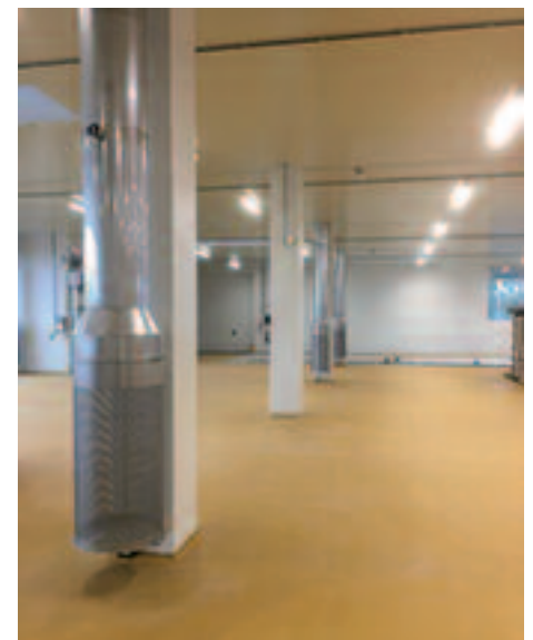
Hygieneorientierter airinotec-HygenicFlow-Verdrängungsluftauslass in Edelstahl, leicht abnehmbar und zu reinigen. Copyright: airinotec
